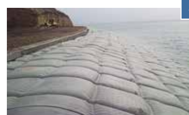
Preenchimento dos painéis com concreto/argamassa fluido
