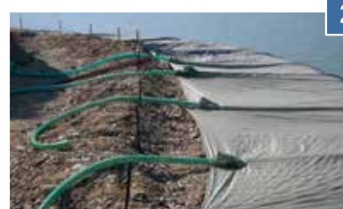
Posicionamento dos painéis
