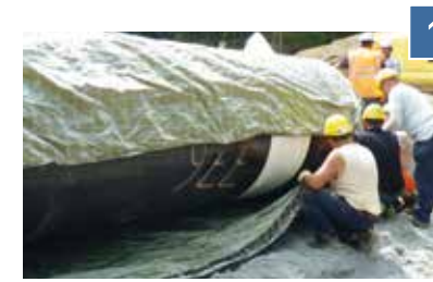
Fixação do tramo a ser revestido
