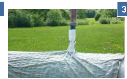
Concretagem através de bocais
