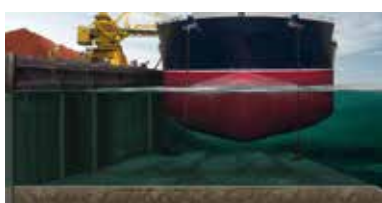
Proteção de berço
