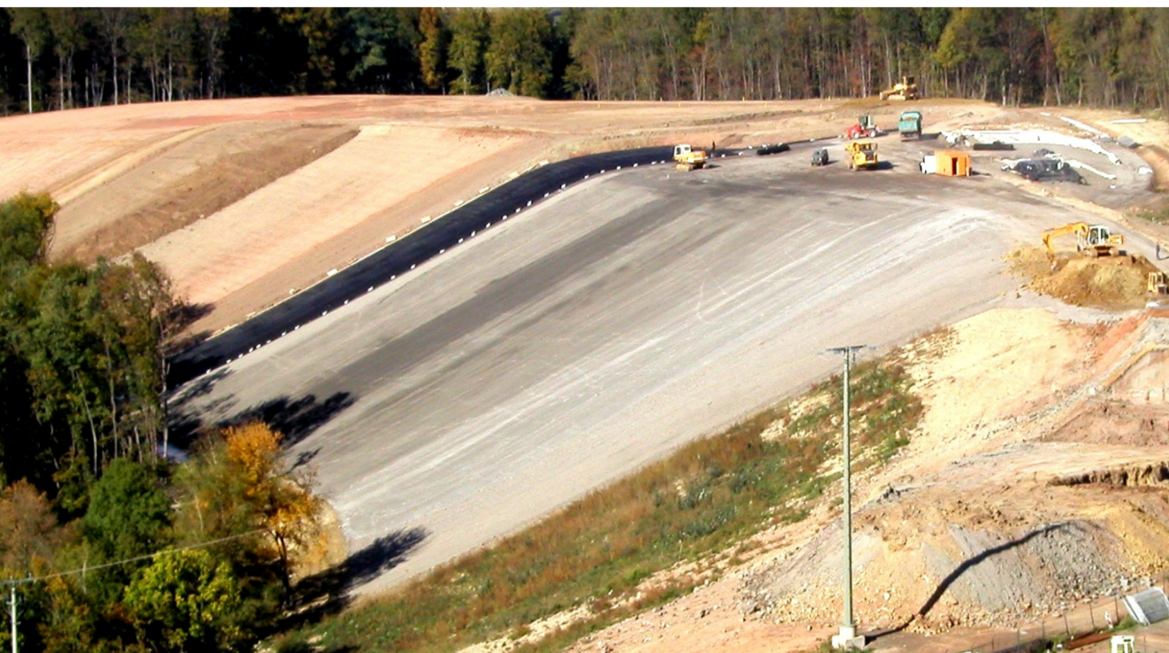
Deponie Koppelwald hohe Auflast im Böschungsbereich durch 2 m hohe Rekultivierungsschicht Böschungslängen von 56 - 79 m Antigleitbewehrung FORTRAC®-T 250 - 300 kN/M Verankerung im Plateaubereich in einem 2 m hohen Randwall
