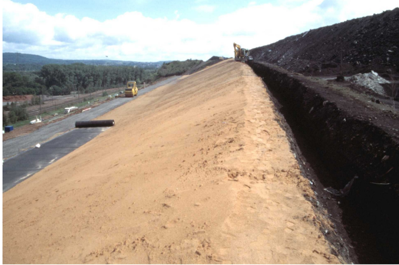
Deponie Dillinger Hütte Böschungslängen bis 31 m; Antigleitbewehrung mit FORTRAC®-T 110-250 kN/m; Verankerung z.T. in speziell angeordneten Tiefgräben in der Zufahrtsstraße
