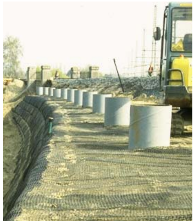
Figure 15. Nordhafengleis Hanover-Ledeburg, construction
