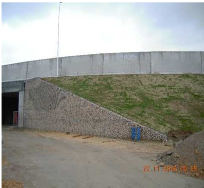
Figura 14 - Aspetto finale di un tratto di muro ad altezza variabile
