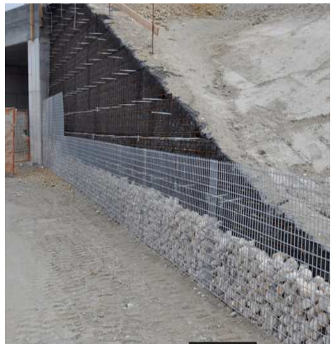
Figura 13 – Muro in fase realizzativa
