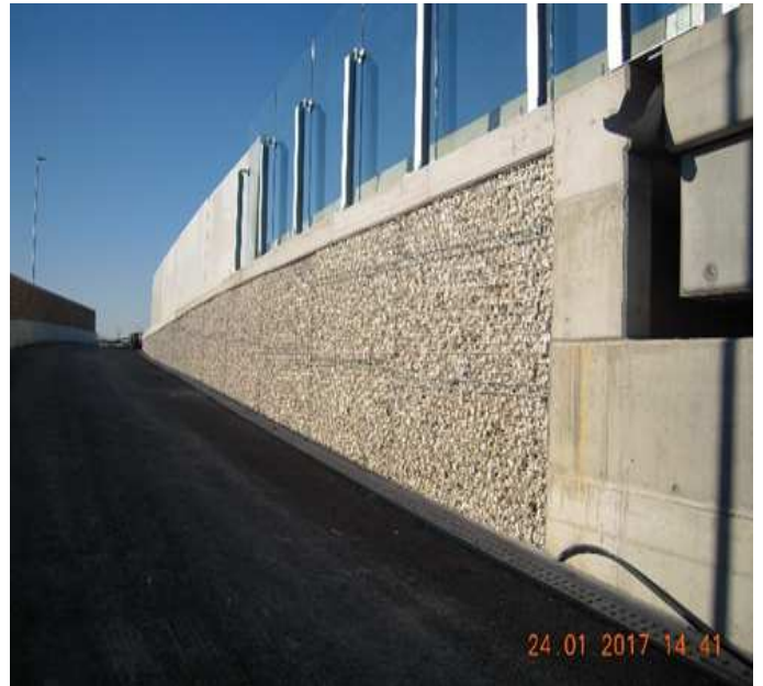
Figura 12. Vista di un muro ultimato. Prospetto Sud asse 2
