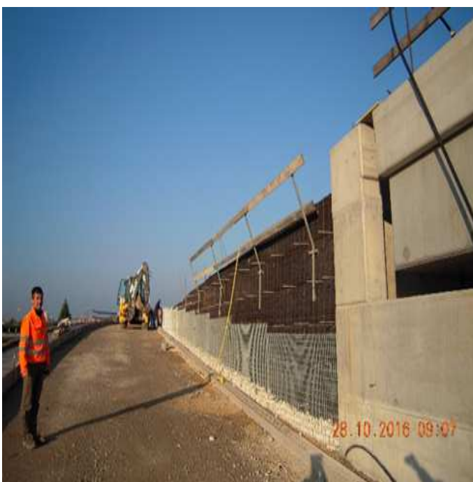
Figura 11. Fasi di riempimento del paramento in pietra
