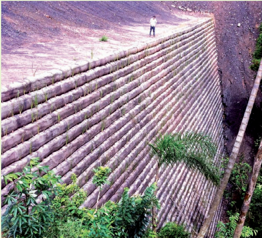
Figura 8 – Detalhe da face durante a construção e muro acabado com início de revegetação
