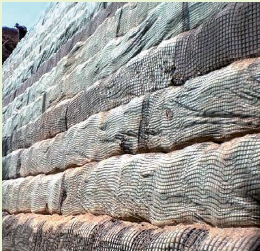
Figuras 7 – Detalhe da face durante a construção
