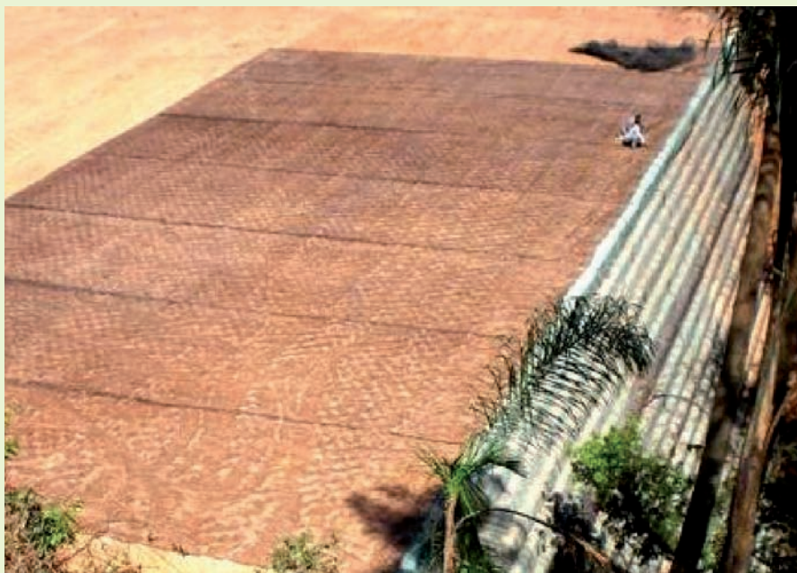
Figuras 6 – Muro durante a fase construtiva
