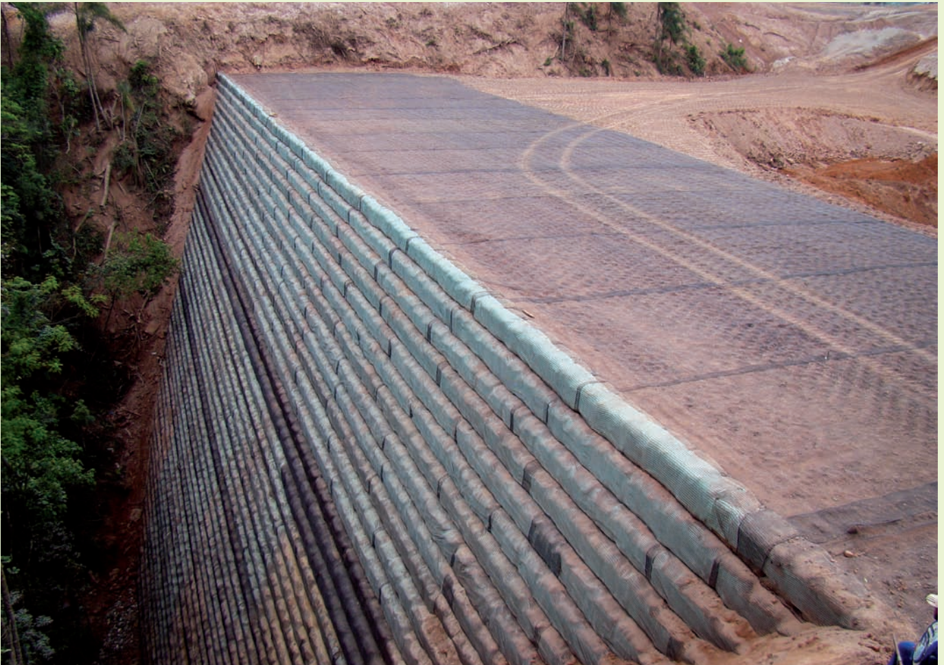
Figura 8 – Detalhe da face durante a construção e muro acabado com início de revegetação
