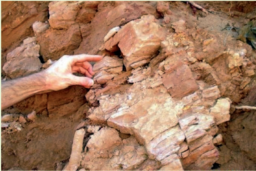
Figura 4 – Detalhe da rocha alterada na fundação
