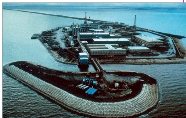
Ilha Endicott, depois do término das obras em 1985
