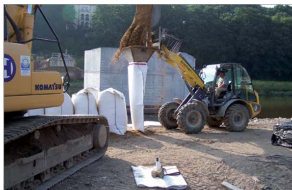
Fig. 2: Processo de preenchimento das bolsas SoilTain Bag com a utilização de um funil
