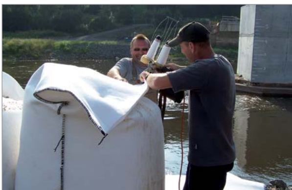
Fig. 3: Fechamento das bolsas SoilTain Bag com máquinas de costura manual
