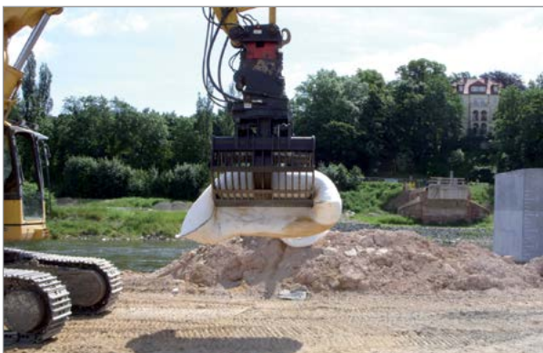
Fig. 5: Transporte por retroescavadeira
