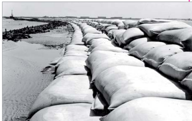
Construção da parte central do dique em Rüstersieler Watt, 1963
