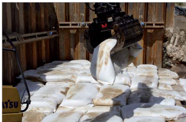
Fig. 6: Posicionamento das bolsas SoilTain Bag
