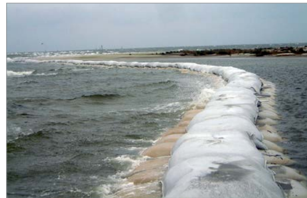
Bolsas SoilTain Bag como proteção de áreas em risco de erosão em um píer.
