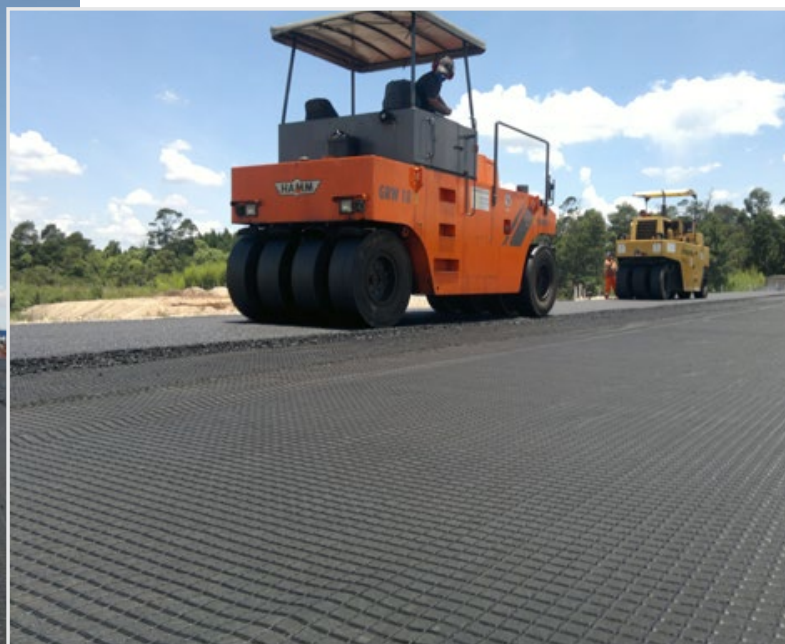
Execução do CBUQ sobre HaTelit® C
