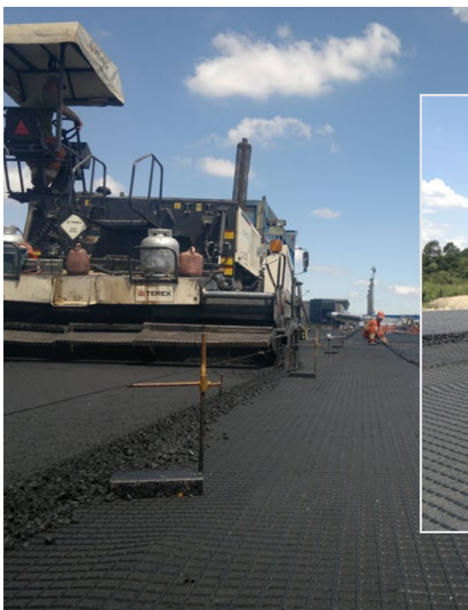
Instalação do HaTelit® C
