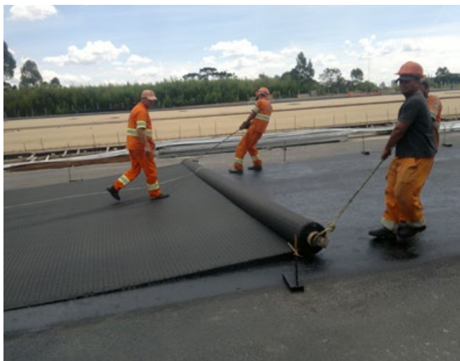
Instalação do HaTelit® C
