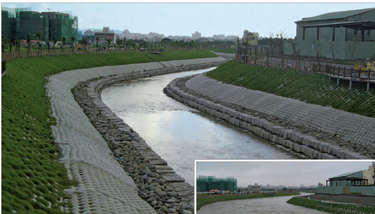
Vista do canal logo após a finalização da obra
