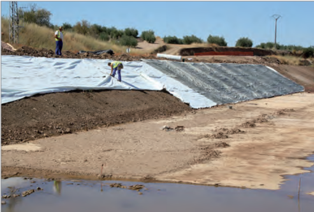
Instalação do não-tecido HaTe ® e do Incomat ® Flex
