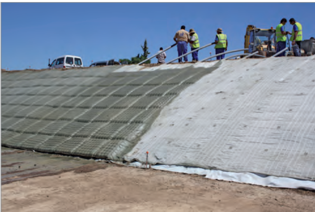
Preenchimento com concreto
