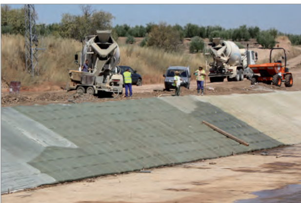
Aterro em execução
