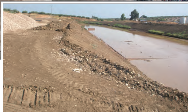
Rio Entrín Verde antes do início da obra
