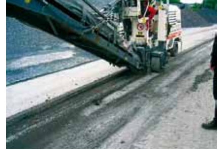
Bild 6: Fräsen der Asphaltdeckschicht inklusive HaTelit
