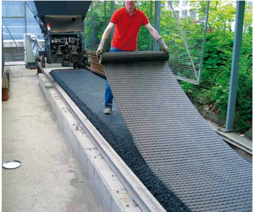
Bild 1: Verlegen der Asphaltbewehrung
