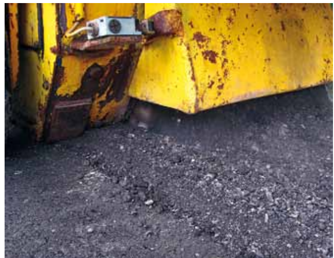
Bild 3: Fräsen der Asphaltdeckschicht inklusive der Bewehrung
