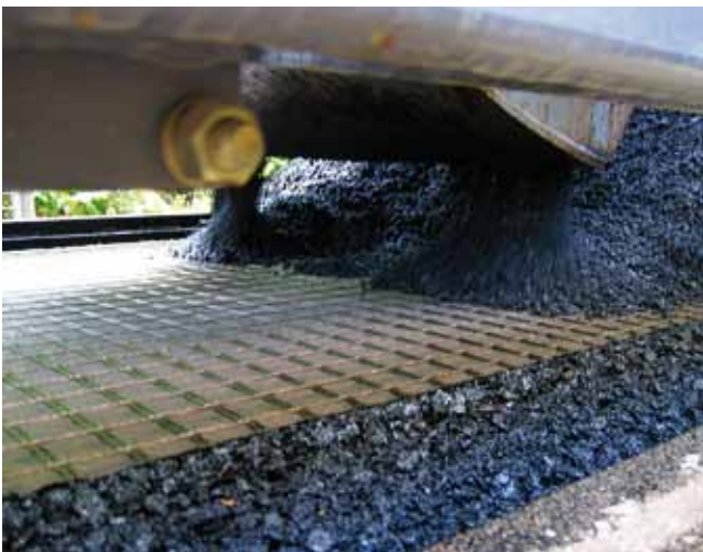
Bild 2: Einbau der Asphaltdeckschicht auf die Asphaltbewehrung
