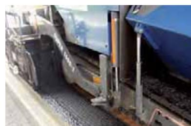
O primeiro passo foi fresar a camada superficial existente e parte da camada de binder. O reforço asfáltico HaTelit® C 40/17 foi então assentado por uma empresa especializada sobre toda a superfície fresada, de acordo com as instruções de instalação do produto.
