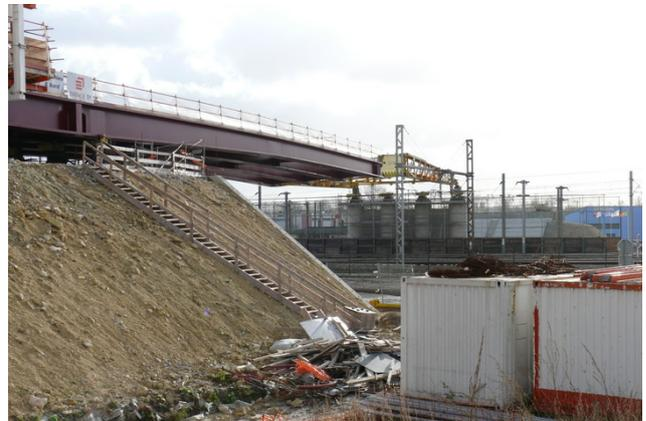
f) Lancement du tablier au dessus des 8 voies ferroviaires
