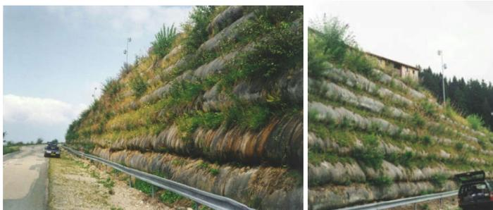
Figure 8. Mur construit en 1977 à Prapoutel les Sept Laux (+1350 m) Alpes (Nappes de Stabilenka® 200
