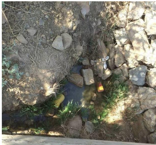
Figure 3. Présence de sources à l'aval de l'instabilité
