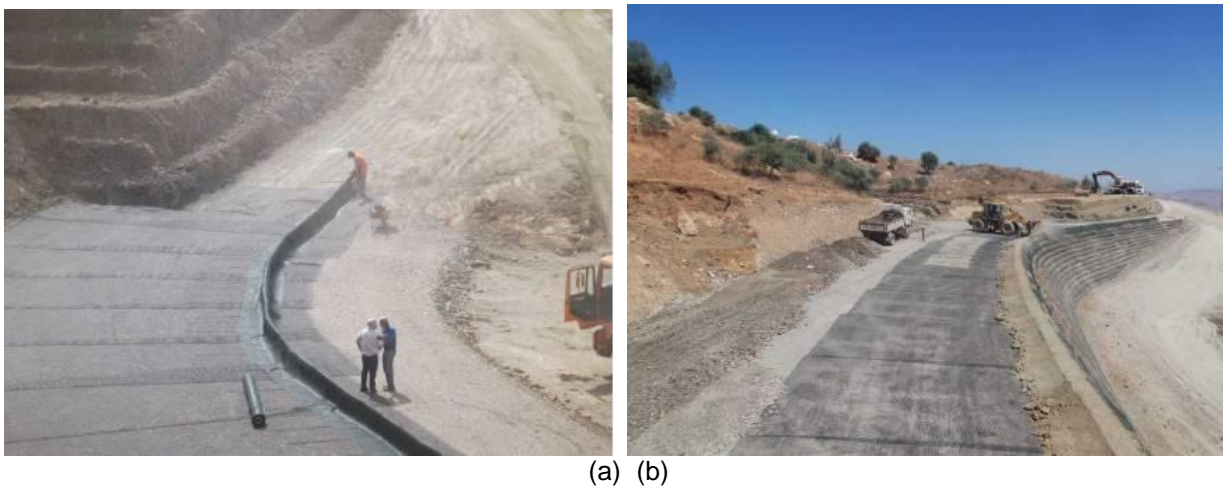
Figure 12. (a) pose de la première nappe de géogrille et de la grille de végétalisation au parement ; (b) montée du massif par couche de 0,5 m.
