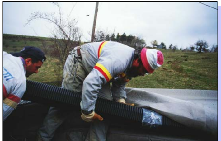
Fig. 7 – posa del tubo di drenaggio all'interno del geocomposito
