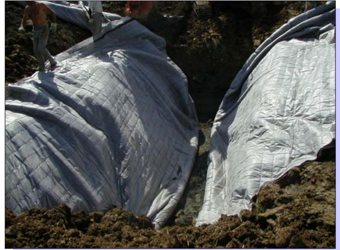
Fig. 6 – posa del geocomposito drenante nella trincea
