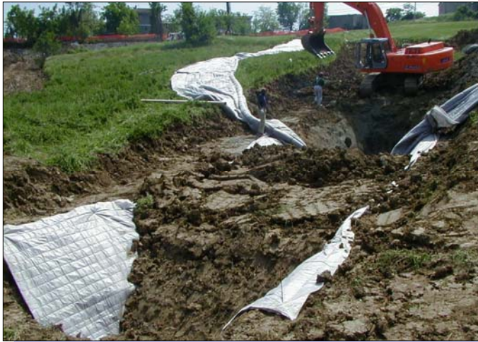
Fig. 8 – fase di riempimento della trincea con terreno dello scavo
