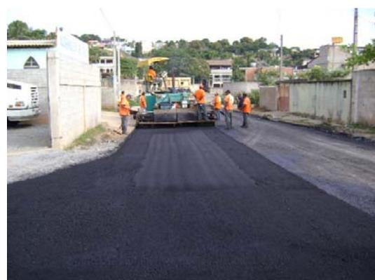
Figura 12. Execução da capa asfáltica em CBUQ (concreto betuminoso usinado a quente).
