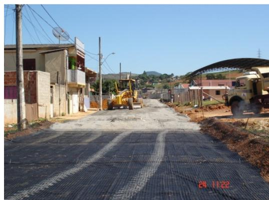
Figura 10. Execução da base em BGS (brita graduada simples).
