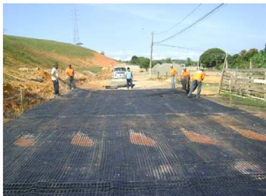
Figura 9. Instalação da geogrelha [GG] Fornit J600.
