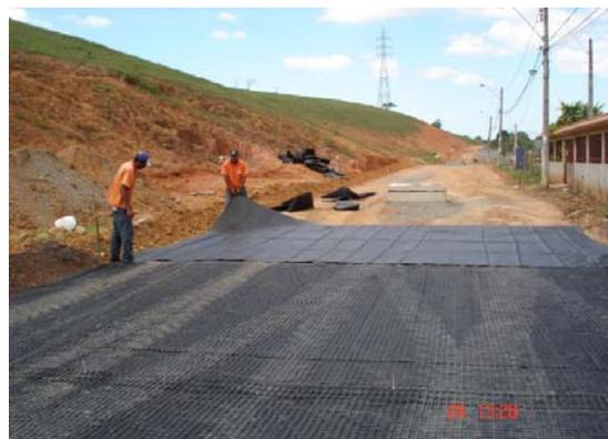
Figura 8. Instalação do geotêxtil [GTW] Hate 55/55.
