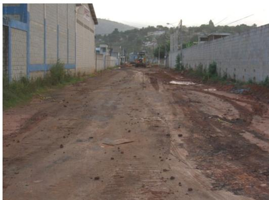
Figura 7. Regularização do subleito para a instalação do geotêxtil [GTW] e da geogrelha [GG].
