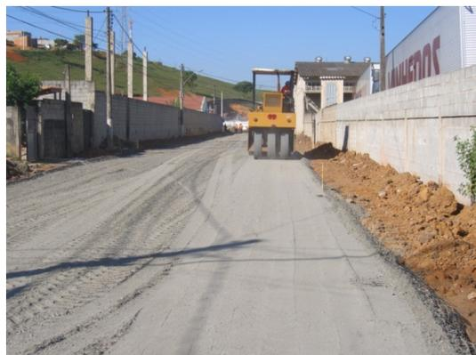
Figura 11. Compactação da base em BGS (brita graduada simples).
