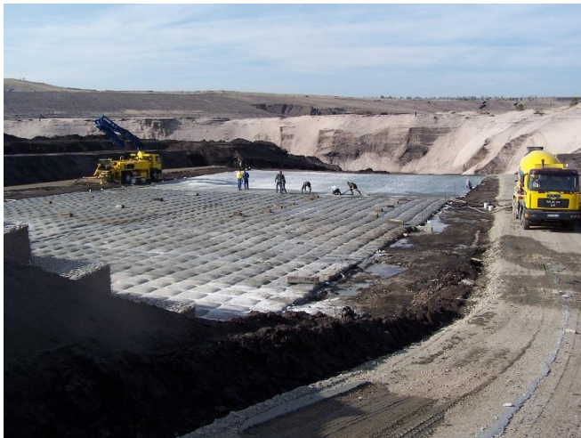
Abb. 7: Installation der Incomat ® Flex 20.118 im Tosbecken des Einlaufbauwerkes
