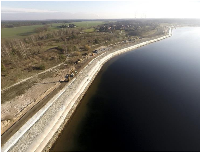
Abb. 11: Fertig gestellter Abschnitt der Kliffsicherung Lieske mit SoilTain® Küstenschutzschläuchen
