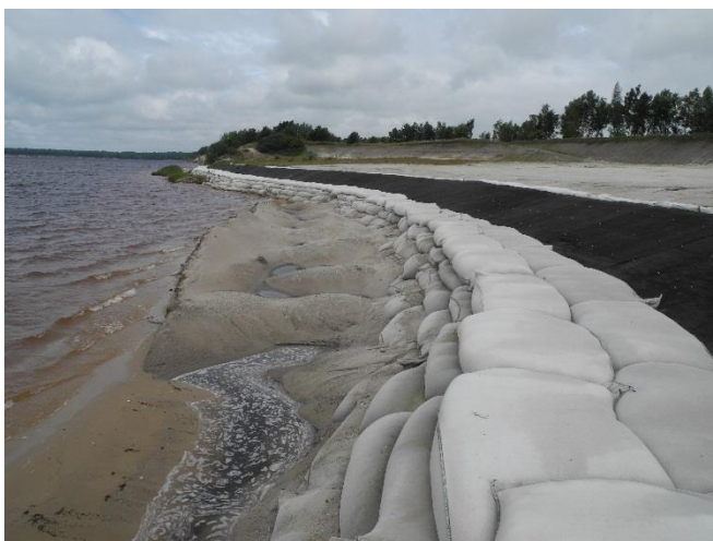
Abb. 9: Mit 1 m 3 Sandcontainern des Typs SoilTain® gesichertes Nordufer des Blunoer Südsees
