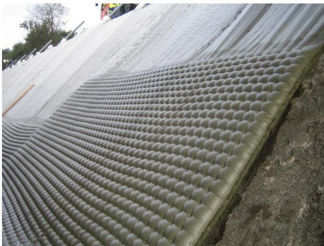
Abb. 6: In der Befüllungsphase befindliche Betonmatte
