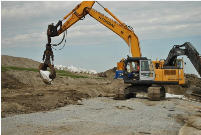
Abb. 3: Installationsvorgang des befüllten und verschlossenen 1 m 3 Sandsackes mit Hilfe eines Baggers mit modifiziertem Sortiergreifer
