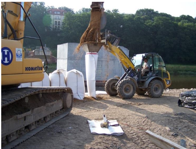
Abb. 2: Typischer Befüllvorgang eines geotextilen Sandsackes mit Hilfe eines mobilen Befülltrichters
