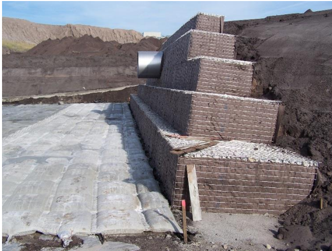
Abb. 8: Mit Incomat® Flex 20.118 gesicherter Bereich des Tosbeckens unterhalb des Einlaufrohres
