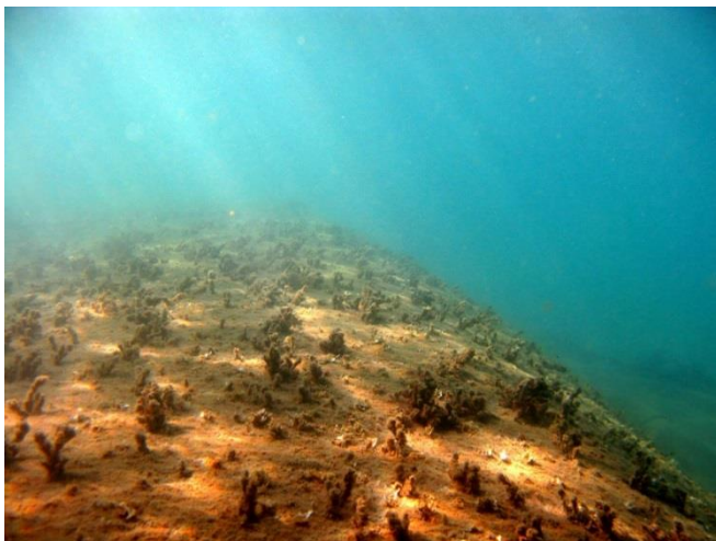
Abb. 1: Durch die Marine Flora und Fauna kolonisierte Oberfläche eines Riffwellenbrechers aus geotextilen Sandelementen (Schläuche) im Mittelmeer ca. ein Jahr nach Installation
