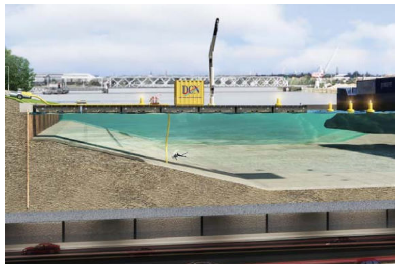
Die 220 mm dicken Betonmatten wurden von Tauchern verlegt
