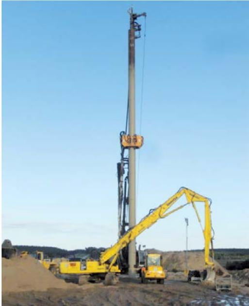
Bild 10. LRB 255 mit 30 m langem Verdrängungsrohr auf einer Baustelle in Polen (Quelle: Josef Möbius Bau-GmbH)
