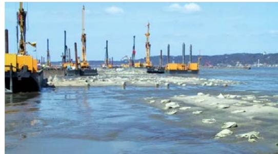
Bild 1. GEC-Herstellung in extrem weichem Schlick von Pontons (Quelle: Josef Möbius Bau-GmbH)
