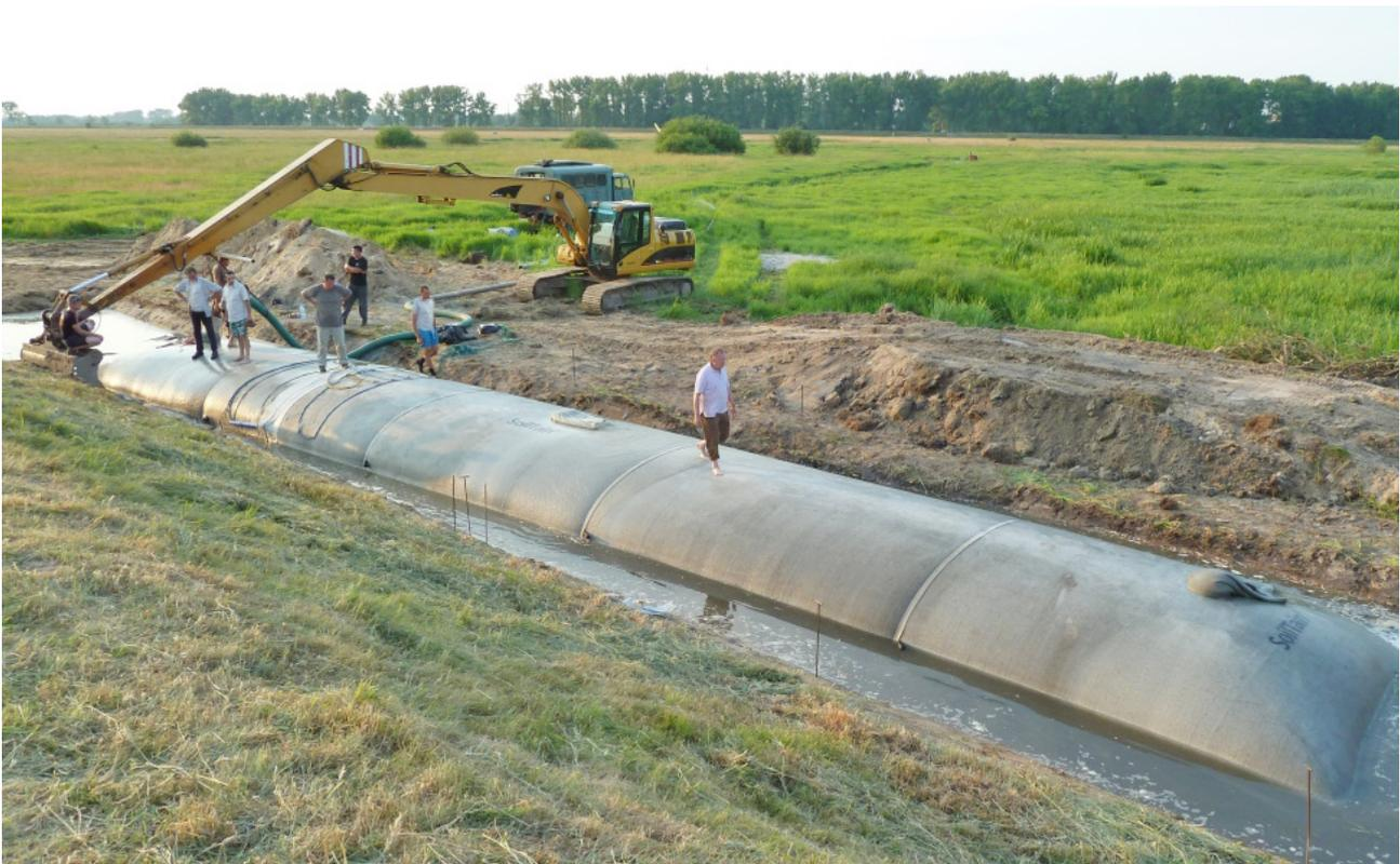
Bild 5: Geotextiler Schlauch während Befüllung
