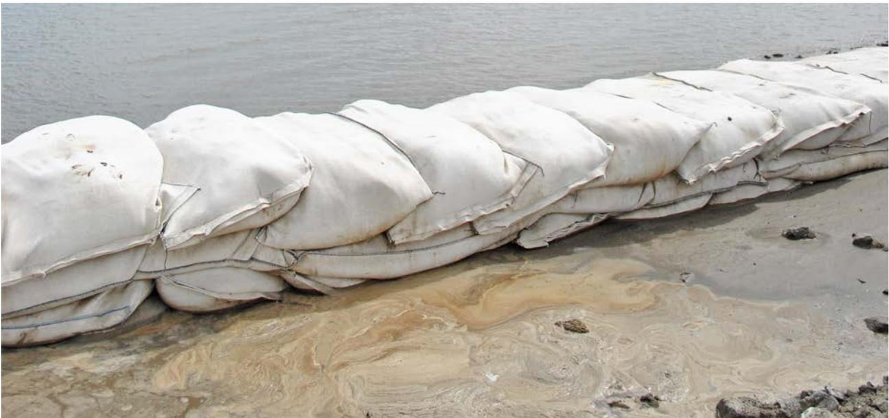
Bild 4: Temporäre Hochwasserschutzstruktur aus 1 m<sup>3</sup> Sandcontainern
