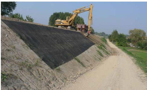
Bild 12: Erosionsschutzgitter während des Einbaus;
