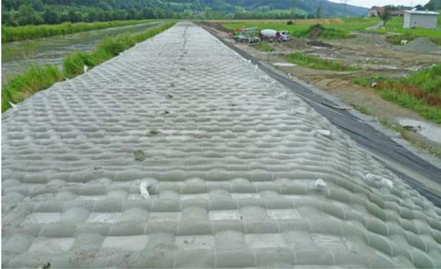
Bild 13: Erosionsschutzgitter während des Einbaus;
