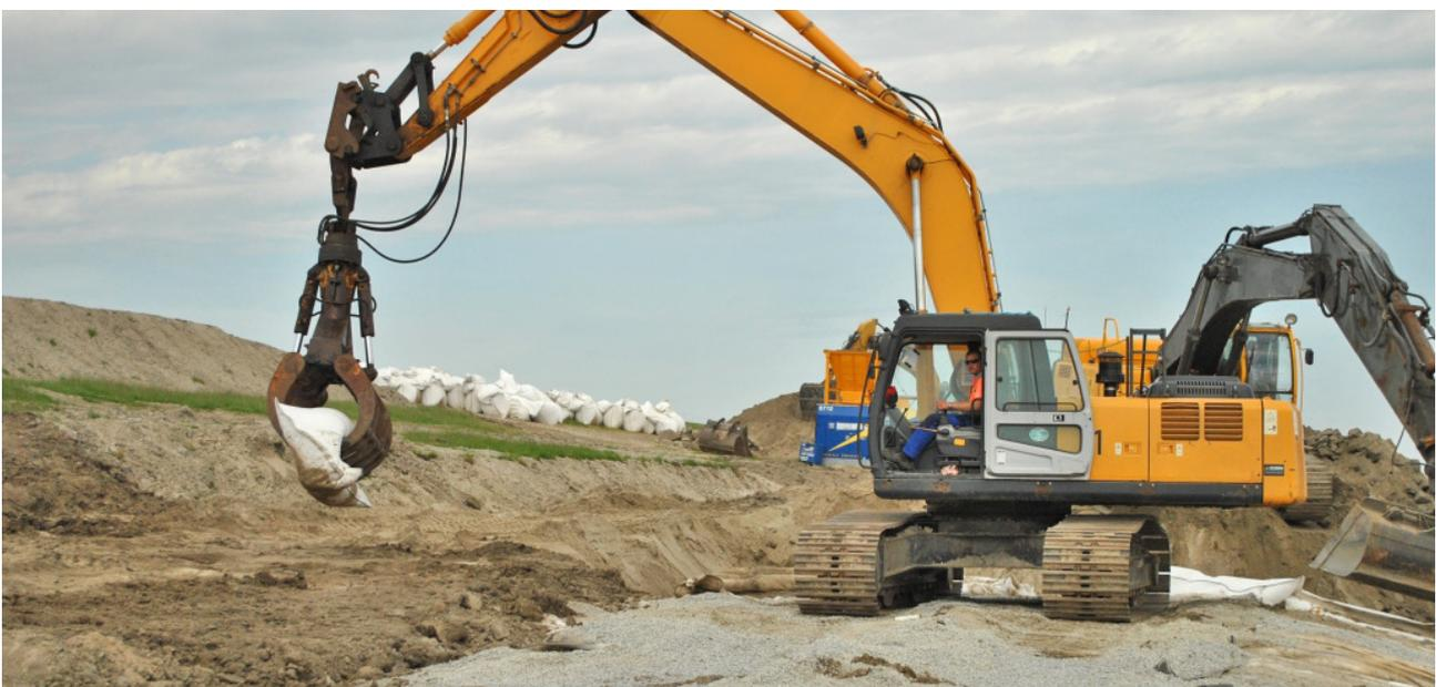
Bild 3: Transport und Verlegung von großen Sandcontainern
