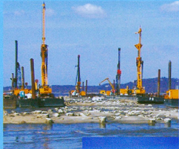
Obra típica em Colunas Ringtrac e detalhe de uma coluna
