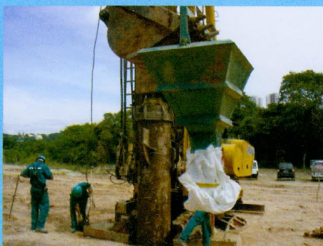
Obra em São José dos Campos (julho 2006)
