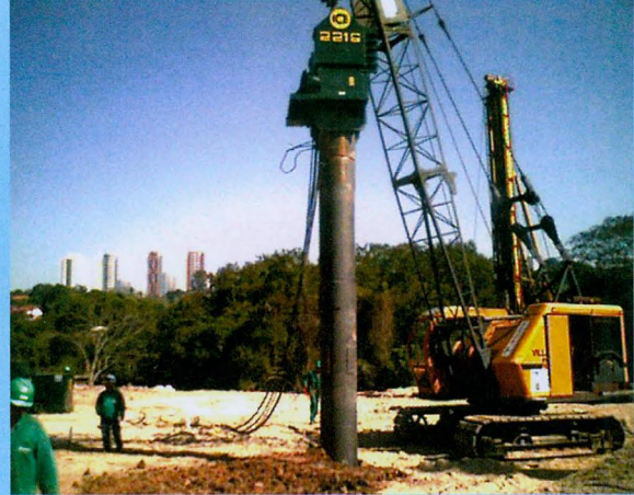
Trabalho em execução, São José dos Campos (SP)
