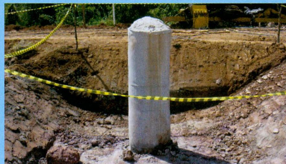
Coluna recém executada
